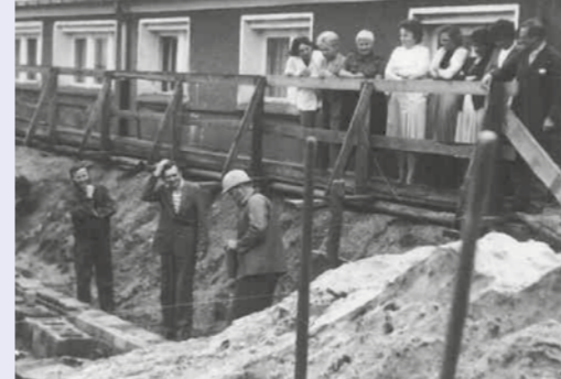
1989 begann der Neubau des Firmensitzes in der Agnesstraße 11
